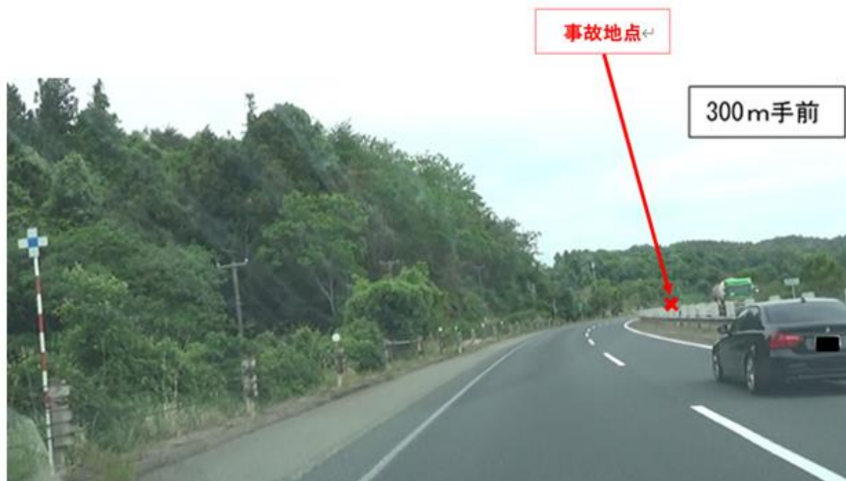
写真5 事故地点前約 300m地点からの見通し状況
