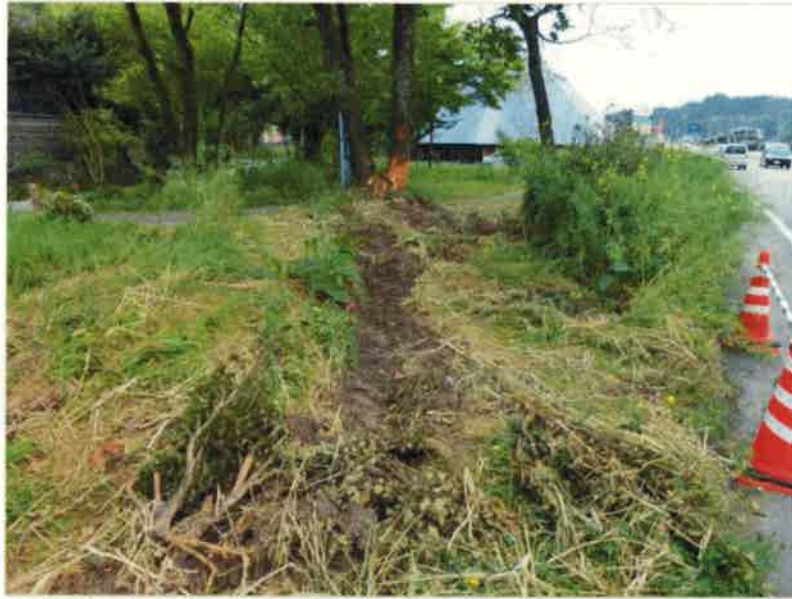
写真4 路外逸脱の状況
